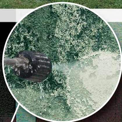
Powierzchnię czyszcimy za pomocą myjki wysokociśnieniowej
