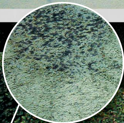
Powierzchnia zaatakowana przez grzyby i glony
